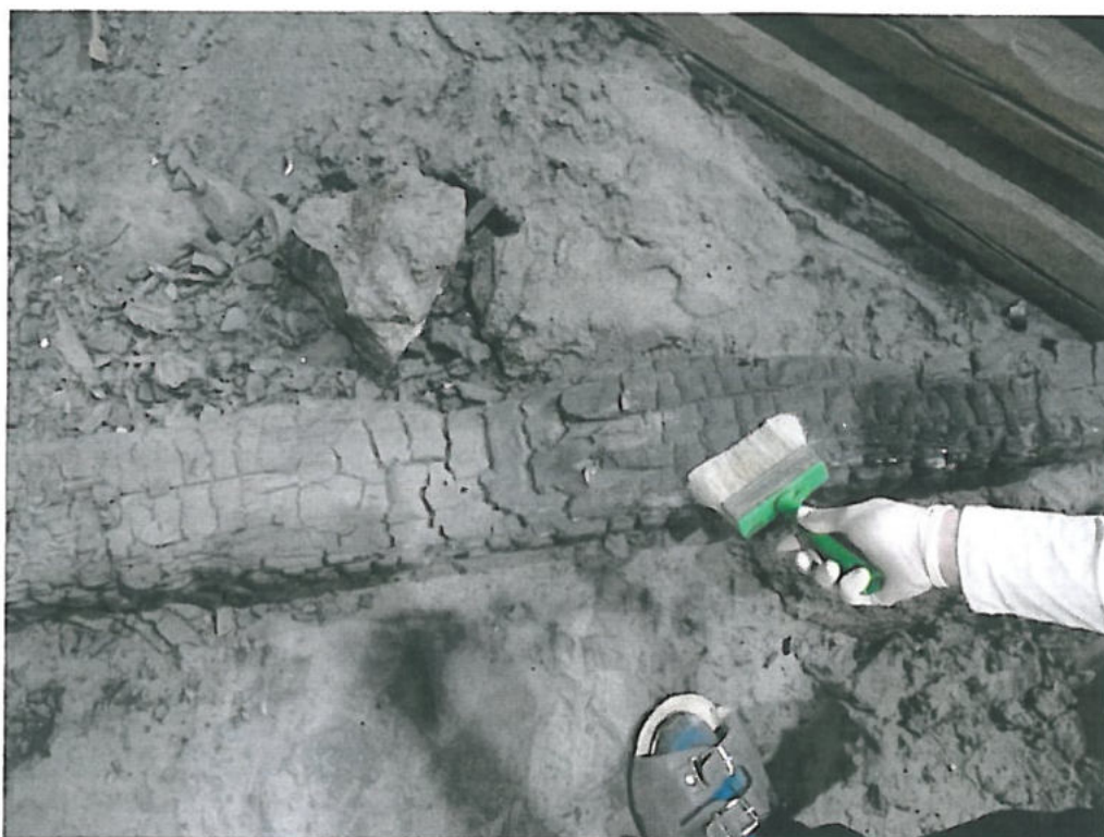
A gerendák portalanításának szakaszai: baloldali rész: átvételi állapot, az ecset körül: száraz portalanítási eljárással végzett munka eredménye, jobboldali részen nedves tisztítás eredménye
